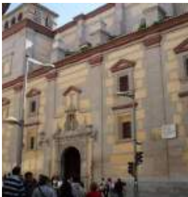
ZONA MAS TRANSITADA DE C/RECOGIDAS
